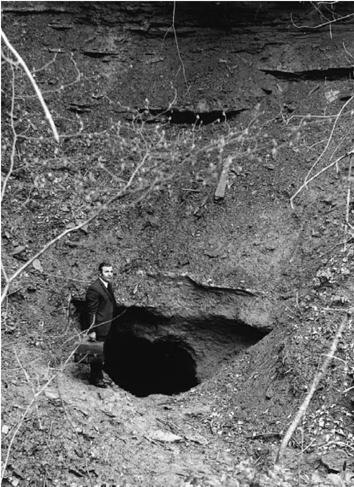
Staltentunnel-Ausgang Seite Ebersecken; Zustand 1972. Foto Verfasser
