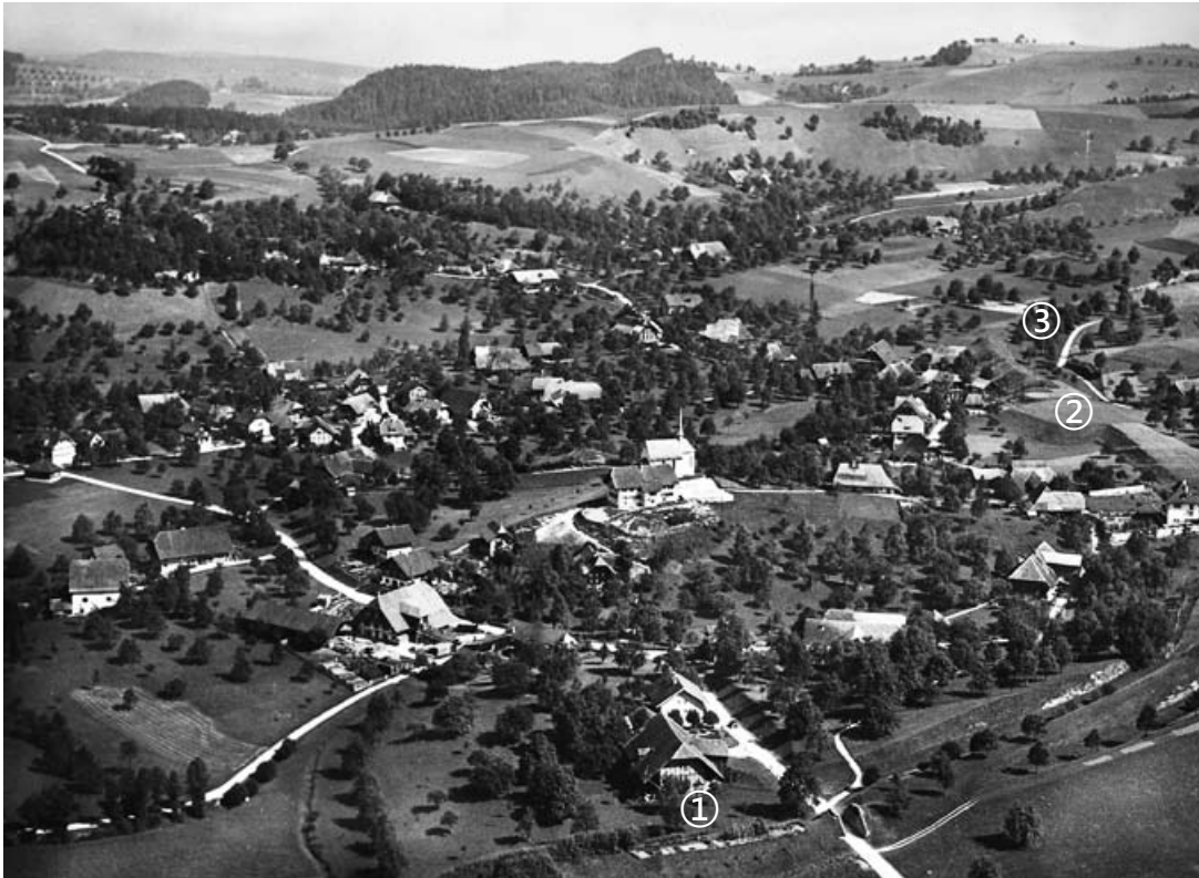
Altbüren in den 1930er Jahren. Der Bahndamm beginnt in der Bildmitte vorne (1), verläuft dann an den rechten Bildrand, wo das verbreiterte Plateau für den Bahnhof auffällt (2), um dann nach rechts in einen Einschnitt und schliesslich in den Tunnel zu münden (3). Foto Alpar
